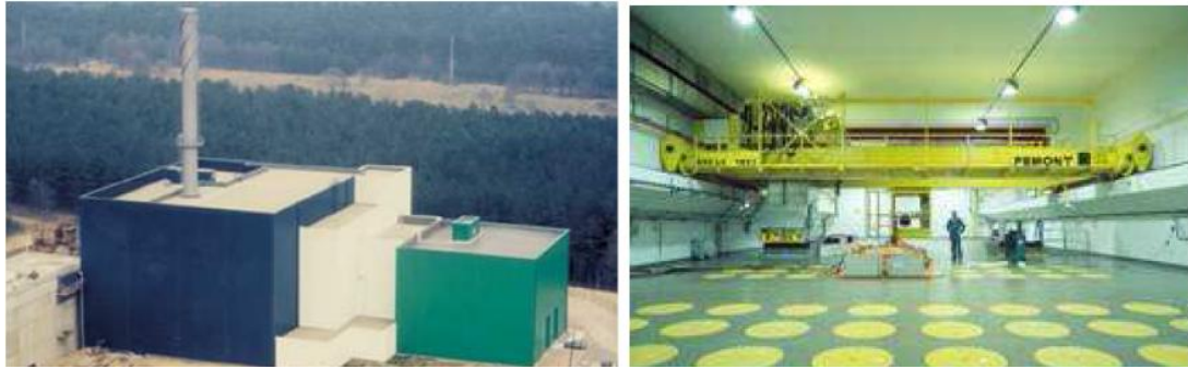
Figure 8 : Bâtiment B136 pour l'entreposage des déchets des catégories B et C
