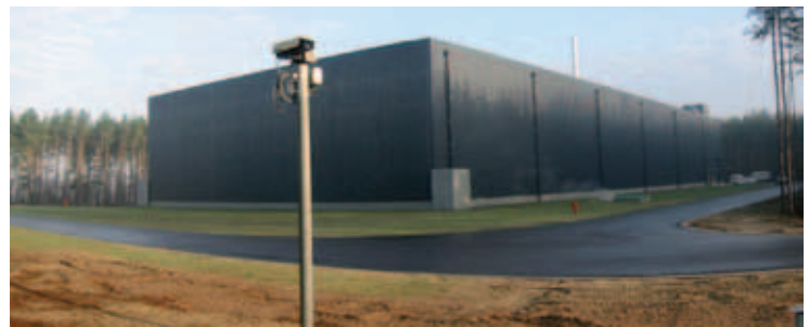
Les déchets de catégorie B sont entreposés dans des bunkers ventilés. Pour l'empilement des déchets, les bâtiments d'entreposage sont équipés de ponts roulants commandés depuis une salle de commande blindée.
