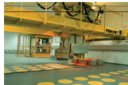
Les déchets de catégorie C, qui dégagent de la chaleur pendant plusieurs dizaines d'années, sont isolés du monde extérieur par un mètre et demi de béton armé, la chaleur étant évacuée par un puissant système de ventilation. Les conteneurs sont empilés à l'aide d'une chargeuse blindée.
